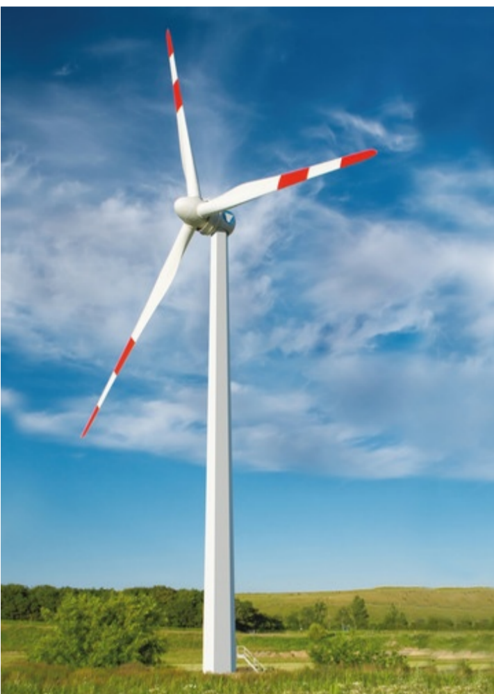
Figure 3: Wind power plant, Retrieved from: http://www.br.de/themen/wissen/energie-windkraftanlagen-holztauerme100.html
